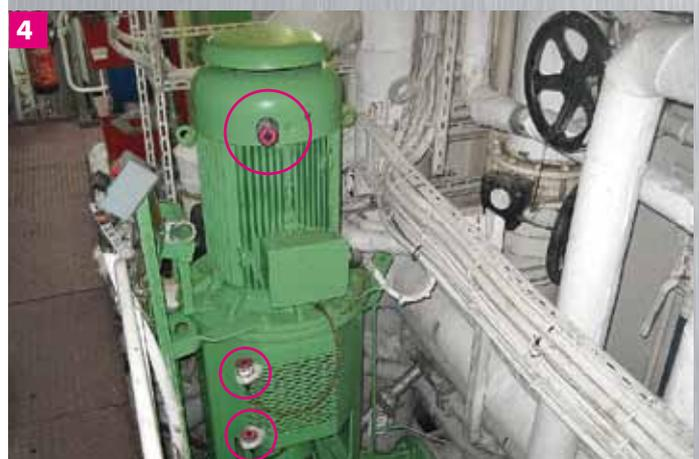
«**simalube®** sostituisce la lubrificazione manuale»
